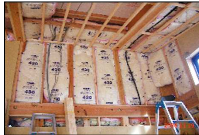
写真8-1-2 繊維系断熱材施工の様子
