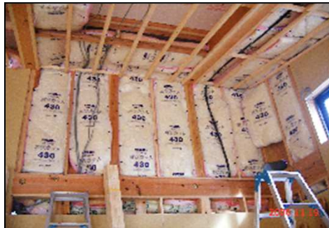
写真2-1-1 充填断熱工法の現場写真
