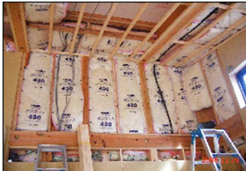
写真1-1-2 繊維系断熱材による充填断熱工法
